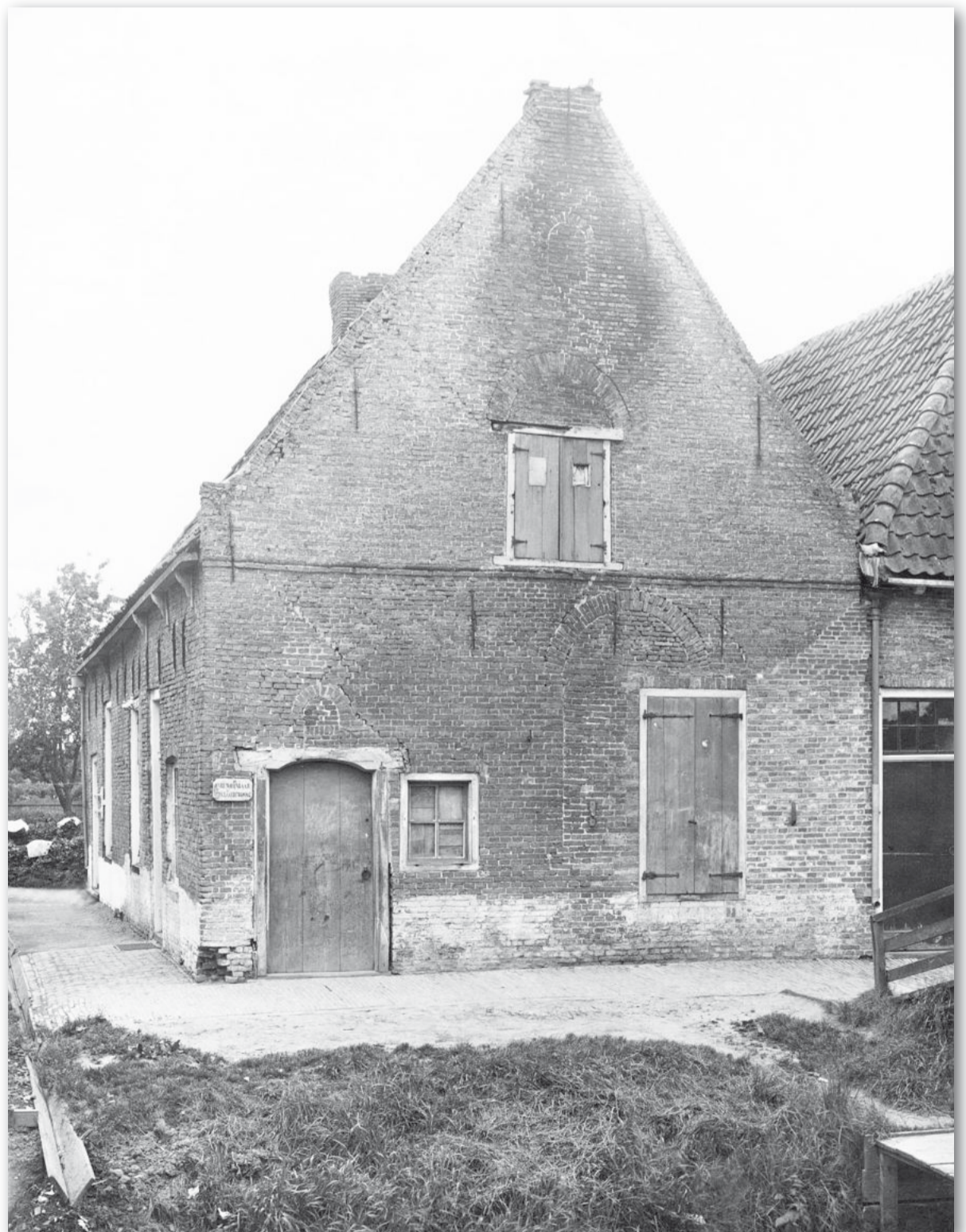
De onbewoonbaar verklaarde topgevel met de termijnbogen nog vaag zichtbaar, september 1932
