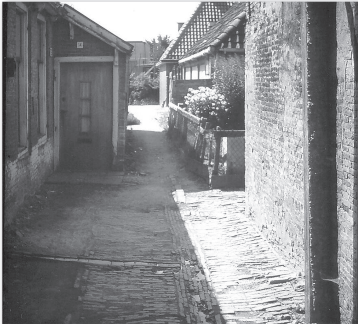
De Noordersteeg in volle glorie met het zicht op de telefooncentrale, met rechts: Warmoesstraat 10, Warmoesstraat 12 en Kade 5 en links: Warmoesstraat 16 en Warmoesstraat 14, 1968-1970
