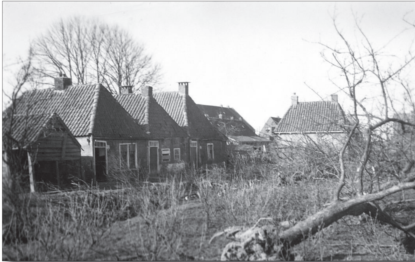
Links de vier 'woningen' van de Pôle en rechts daarvan het alleenstaande huisje nabij de Koem met daar tussenin het dak van de gemeentewerken (ooit stoomoliefabriek, nu wereldwinkel) en van Warmoesstraat 59 (nu Bauke Postma), 1955
