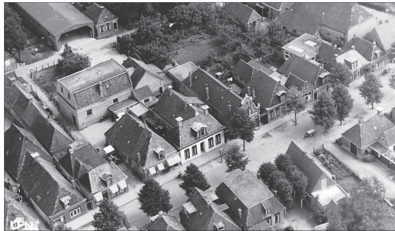
Overzicht van het voormalige eigendom van het Burgerlijk Armbestuur. We ontwaren de wit bepleisterde gevel van het huis van Jippe Faber, het bankgebouw met de ruime tuin waar ooit de liggenden van het Groen Kruis stonden en de grote zaal van het oude armhuis, 1952.
